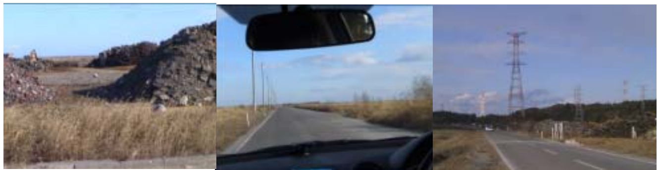
図4 南相馬市津波被害区域の写真
