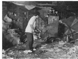
図1 発見された線源をトングを用いて鉛容器に収納する
