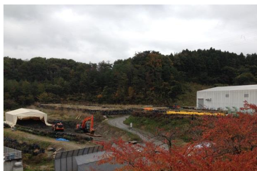
写真-4 保管汚泥の掘削状況
