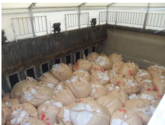
写真－1 水処理施設内に保管中の脱水汚泥
