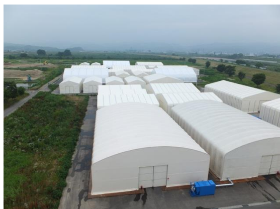
写真-5 県北浄化センターに設置された下水汚泥保管用テント
